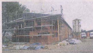
Noch verdeckt das Gerüst die Fassade aus handgeschöpften Ziegeln und rostroten Fugen.
